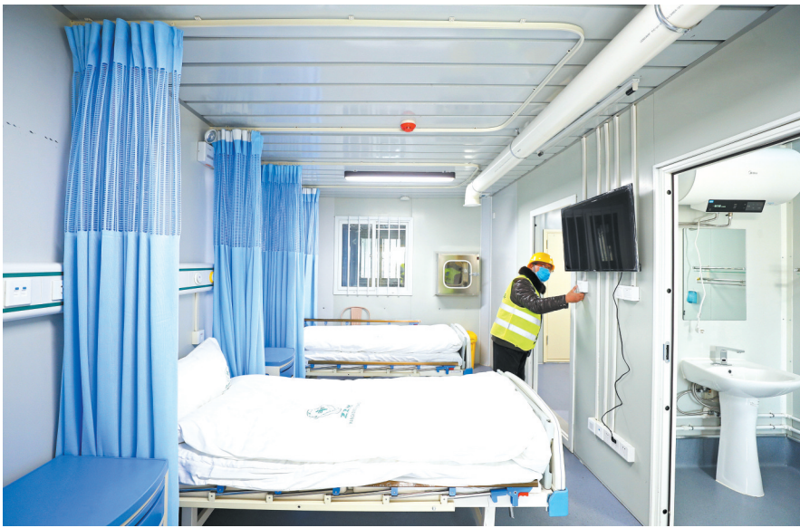
2月7日，施工人员对交付的河南版“小汤山”医院病房进行灯光测试。 史 尧/摄
