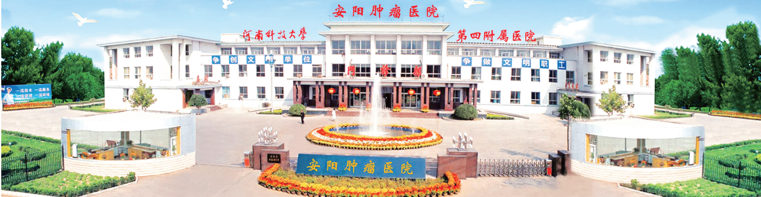
图为安阳肿瘤医院门诊楼,该楼2017年被安阳市政府评为“历史文化建筑”。该建筑由我国著名建筑设计师王庭惠亲自主持设计。
