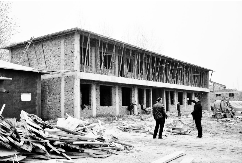
平舆县人民医院帮扶的陈刘村卫生室项目正在施工
