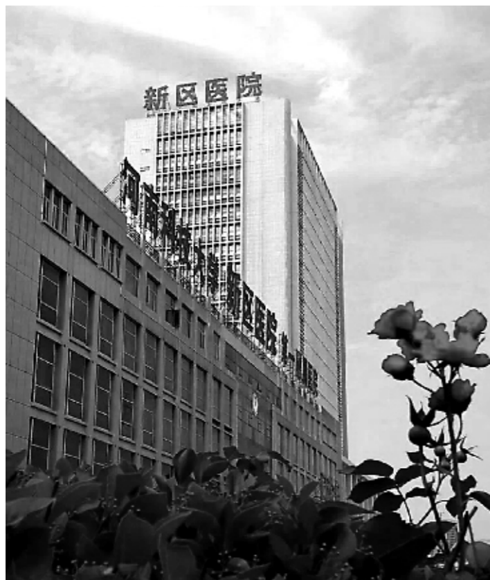
河南科技大学第一附属医院新区医院外科病房大楼
