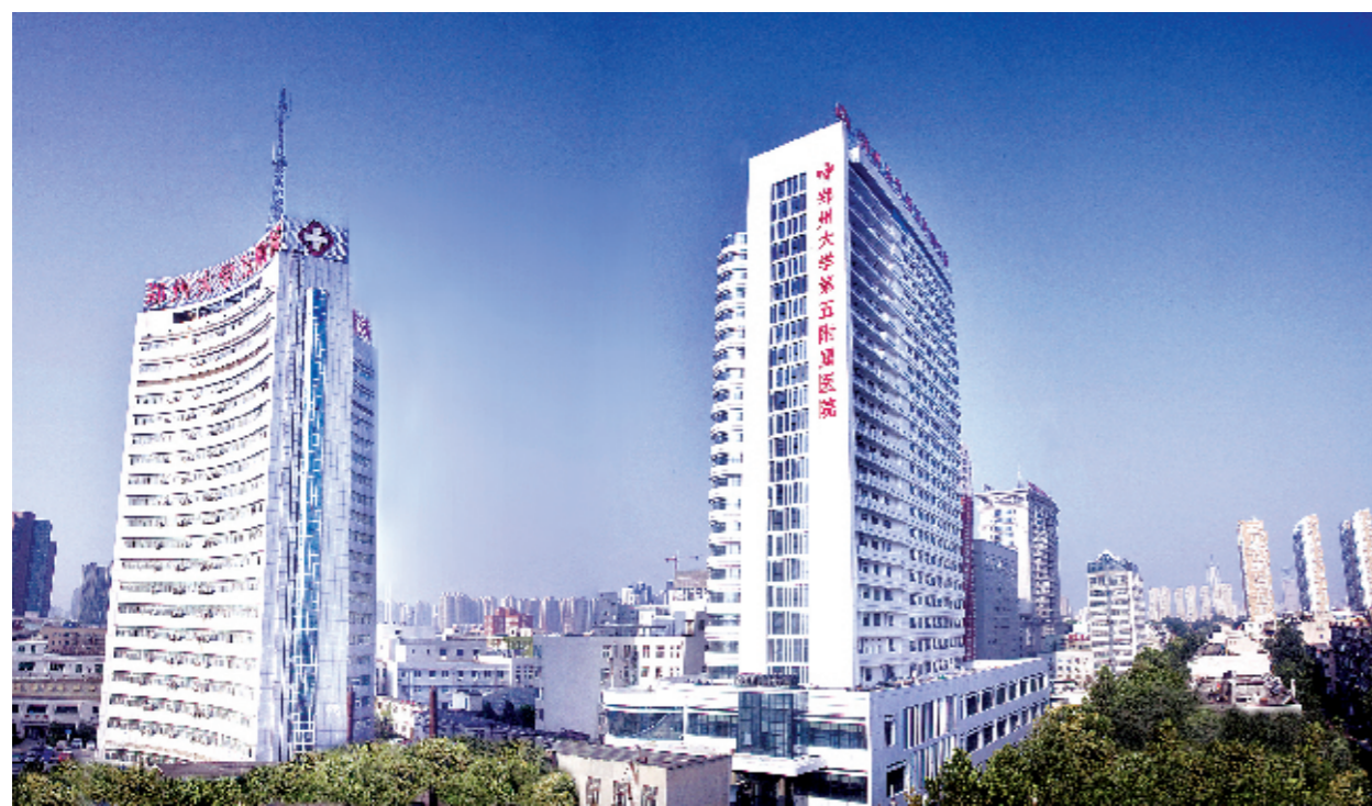
医院1号、2号病房楼全貌(图片右侧2号病房楼为医院新建的25层综合病房大楼)
