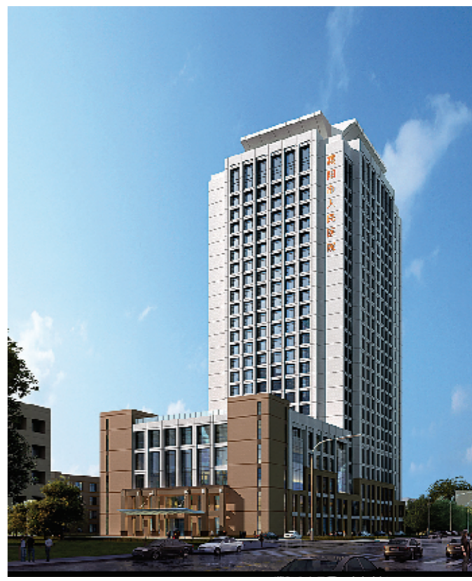
正在建设的新病房大楼
