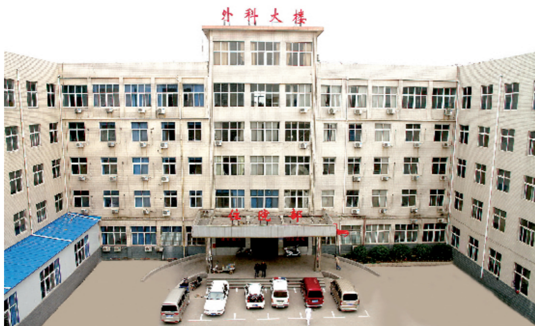
汝州市第二人民医院住院部
