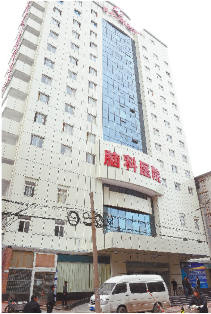
脑科医院大楼
