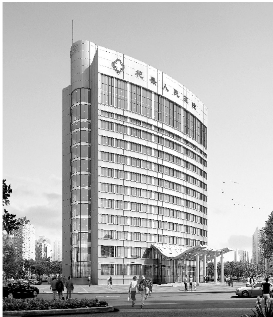
杞县人民医院综合病房楼
